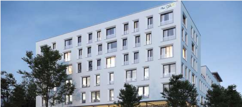
Das DAVit ist eine Mixtur aus Büro- und Boardinghaus. Quelle: Kolb + Partner Immobilienkompetenz3
