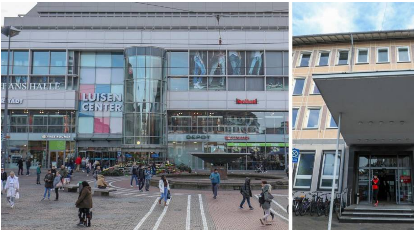
Die städtischen Ämter mit Publikumsverkehr ziehen vom sanierungsbedürftigen Stadthaus Grafenstraße ins Luisencenter. (Foto: Guido Schiek)
