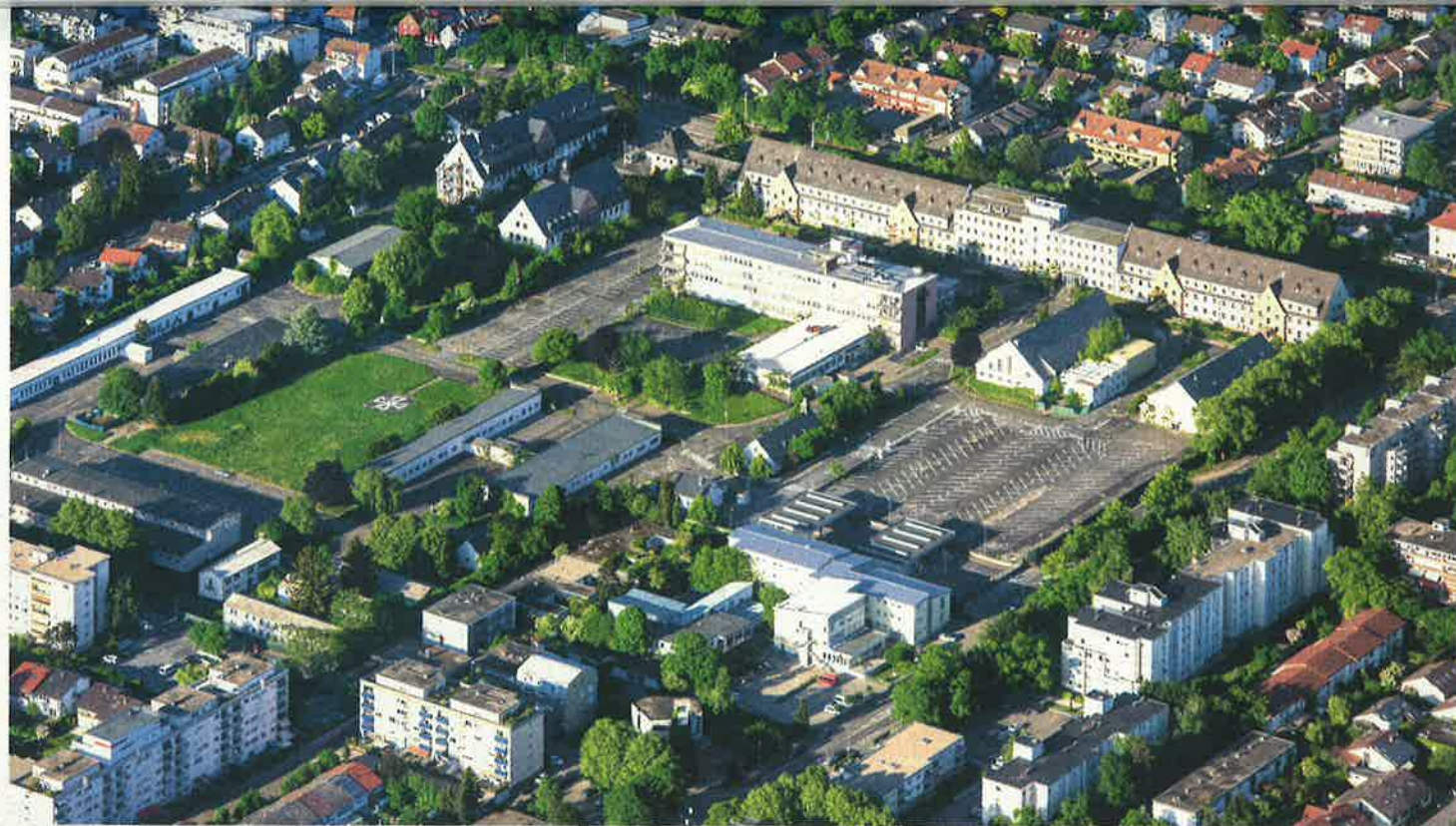
Blick auf das Hospital-Areal, wie es sich derzeit darstellt. Binnen vier Jahren soll es ein emissionsarmes Quartier für die Mitte der Gesellschaft werden. Quelle: Venus
