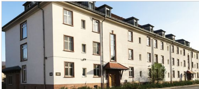
Das sanierte Gebäude 103 ist Teil des hip.
